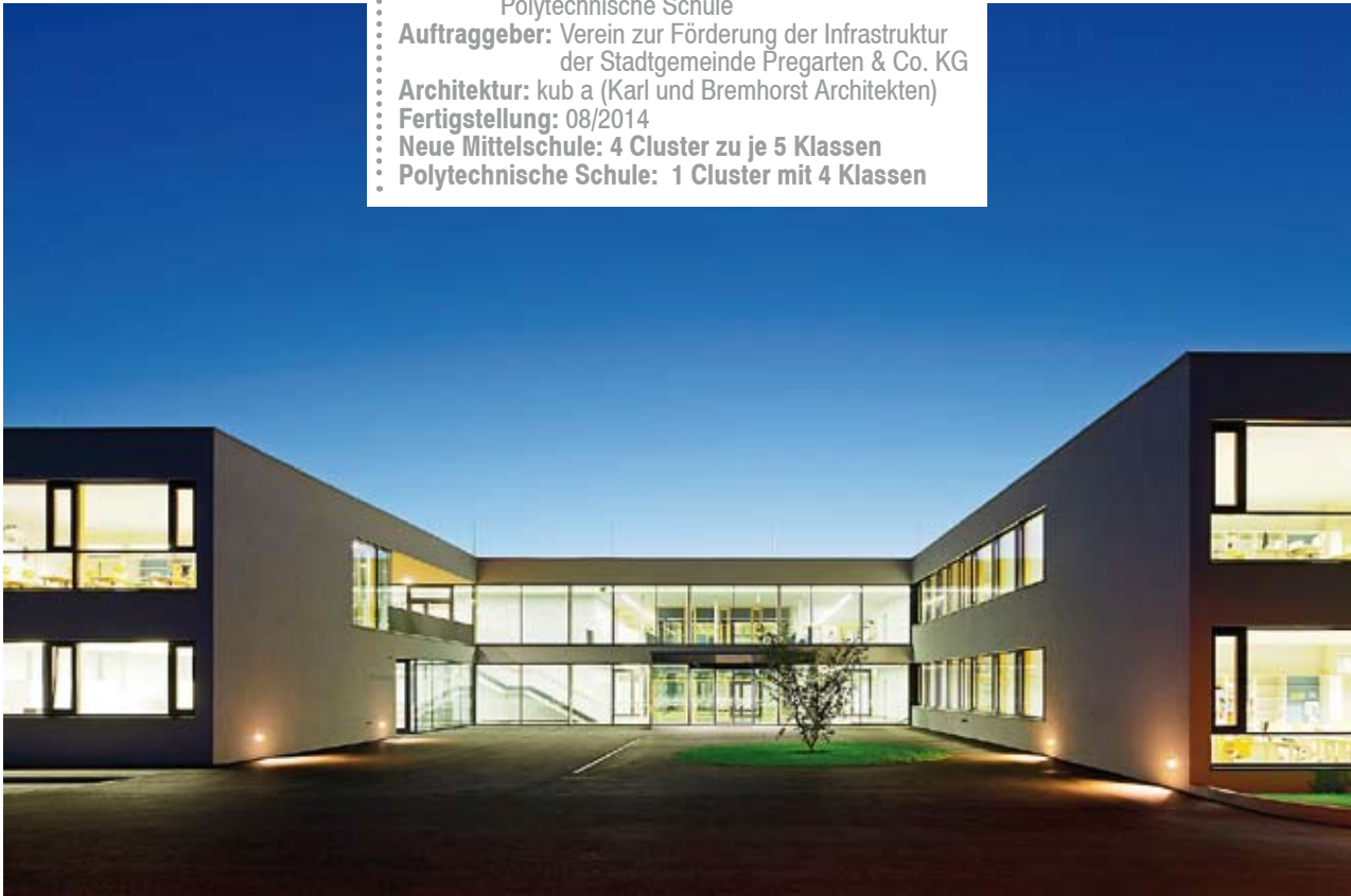
51 Außenansicht Schulzentrum Pregarten; Foto: Rupert Steiner
