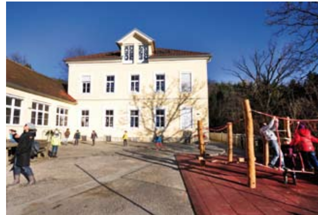
36 Die bestehende Schule blieb erhalten und wurde umstrukturiert; Foto: Stefan Mandl
