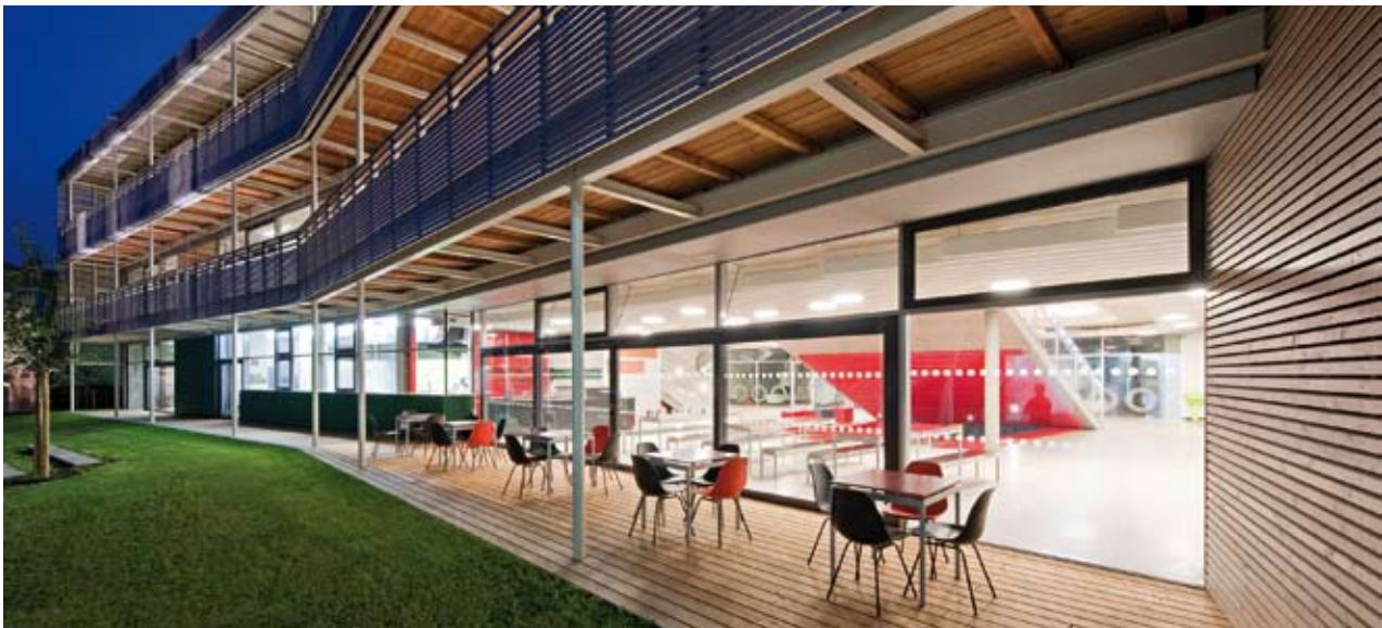
20 Überdachter Essbereich; Foto: Hertha Hurnaus
